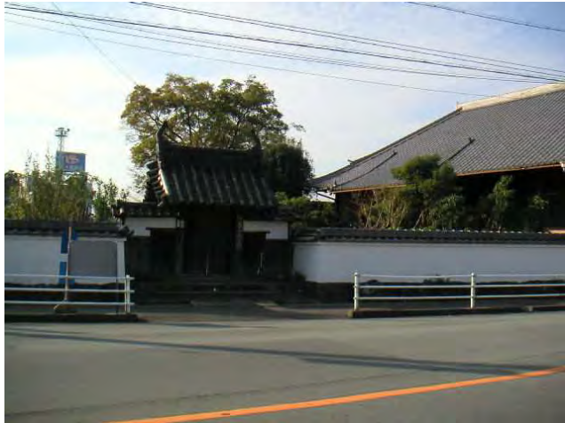
摂取山 善光寺(天台宗)150 前後に開山 威勝寺大師堂を移築
