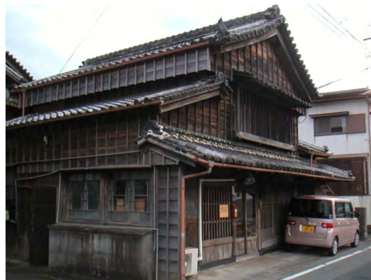
肥料問屋 西川家 母屋は明治初期の建造
